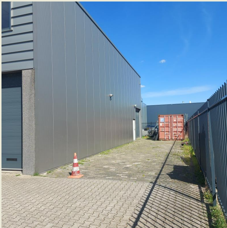
Pad aan de zijkant naar overheaddeur aan de achterzijde
